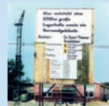
Das neue Lager wird gebaut.
